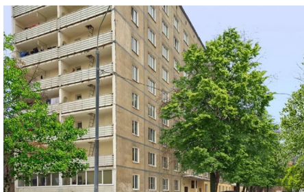
г. Москва, ЖК «На Клинской» Узел коллекторный квартирный «Пулсар» в исполнении чёрная сталь – 1147 шт. Узел коллекторный этажный «Пулсар» в исполнении чёрная сталь – 151 шт.
