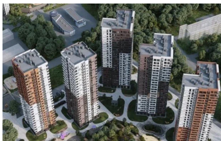
Московская обл., г. Одинцово, «Одинград. Квартал Семейный» Узел коллекторный этажный «Пулсар» в исполнении чёрная сталь – 153 шт.
