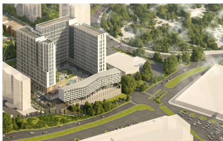
г. Уфа, ЖК «Биосфера» Счетчик воды квартирные – 2 258 шт. Теплосчетчики квартирные – 583 шт.
