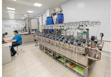
Метрологическая лаборатория оборудована проливными установками для поверки счетчиков воды и тепла Ду15-200
