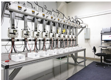
Стенд поверки и тестирования электросчетчиков
