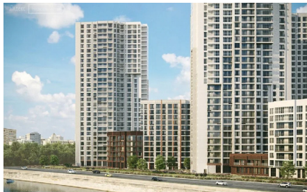
г. Москва, ЖК «RiverSky» Счетчики воды – 5 990 шт. Теплосчетчики квартирные – 1 352 шт.
